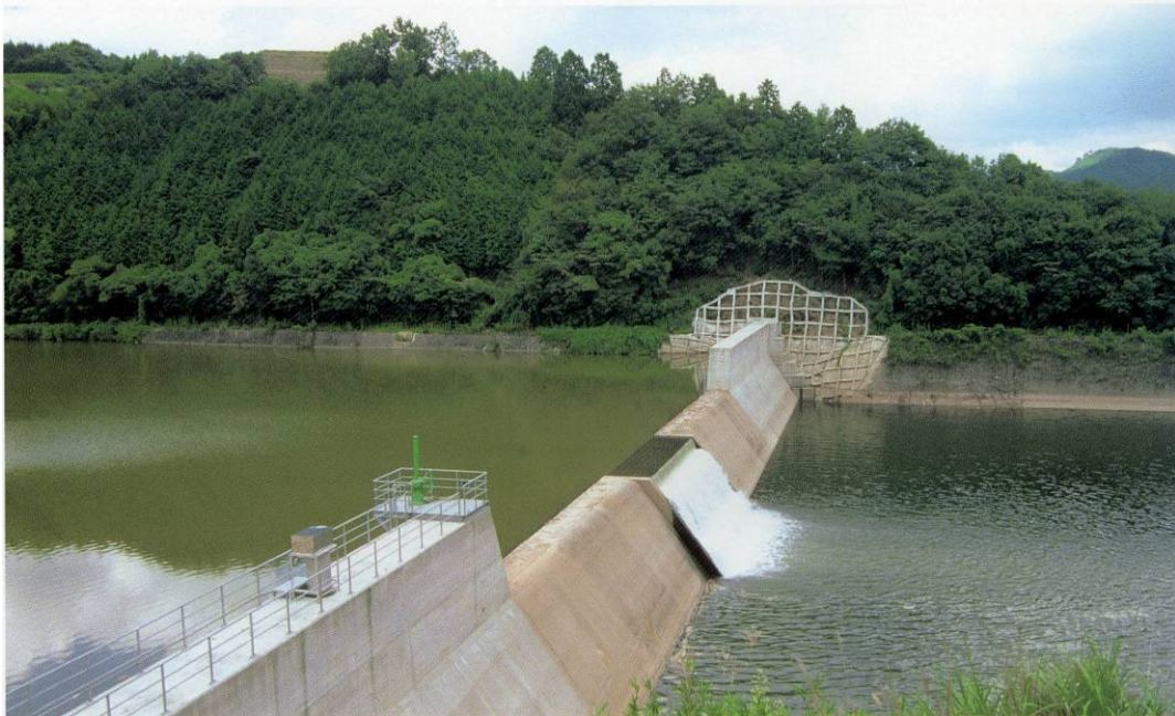
図 4.5.1-2 副ダムの設置状況
